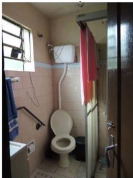
FOTO 09 – Casa Superior – banheiro
